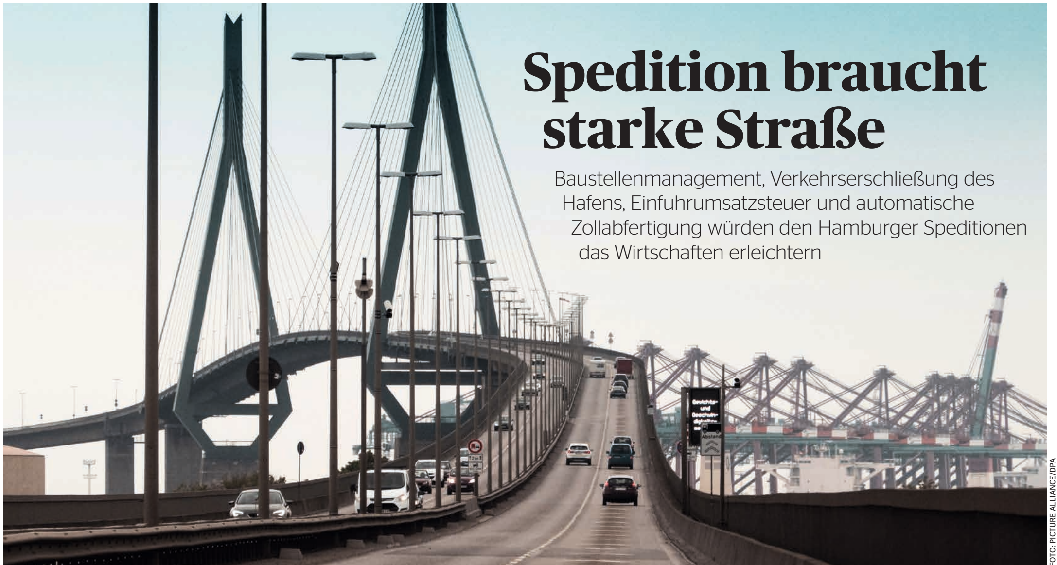
Die Köhlbrandbrücke im Hamburger Hafen ist eines der Wahrzeichen der Hansestadt.
